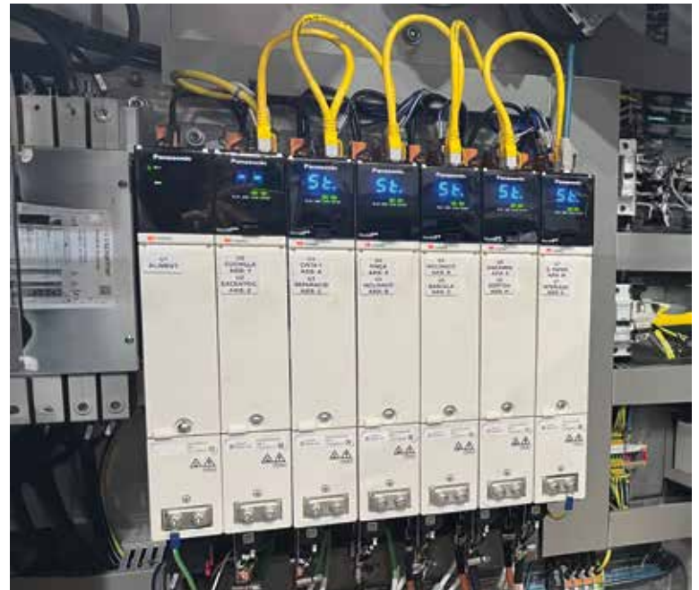
Il motion controller è stato scelto per le sue capacità di controllo di fino a 32 assi, la comunicazione Ethercat e le funzionalità di programmazione con Codesys
