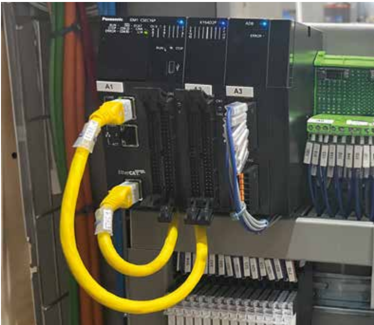
Il motion controller GM1 integra la logica programmabile e il controllo del movimento in un unico dispositivo
