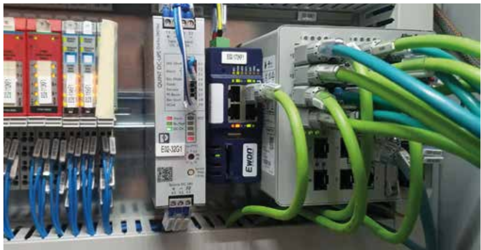
Sulle macchine sono stati installati i gateway/router Ewon Cosy 131 e Flexy 205
