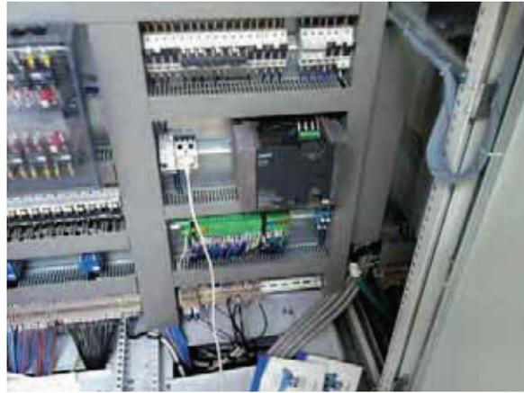
I PLC sono programmati con tutti i dati per il controllo dell'energia in loco o da remoto
