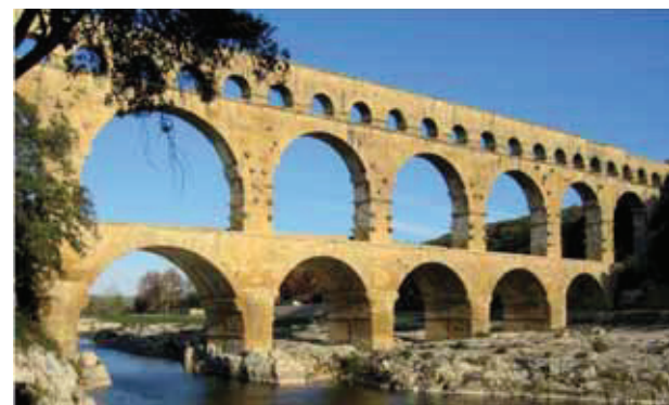
Figura 1 - Pont du Gard, ponte di 49 metri di altezza e 273 di lunghezza, costruito intorno al 19 a.C. dai dominatori Romani della colonia Gallica di Nemasus (attuale Nîmes). Inserito nel tracciato di un acquedotto di 50 km che convogliava l'acqua della sorgente carsica di Uzès alla colonia di Nemasus, permetteva l'attraversamento del fiume Gardon mantenendo la pendenza graduale di 1 metro ogni 3.000 (0.3%, ovvero appena 17 metri di dislivello sull'intera estensione di 50 km).
