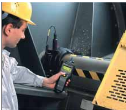
Monitoraggio delle vibrazioni per la manutenzione predittiva
