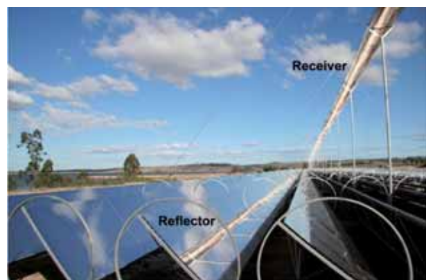
Figura 1 - Impianto di generazione solare a specchi lineari di Fresnel (Ausra media department)
