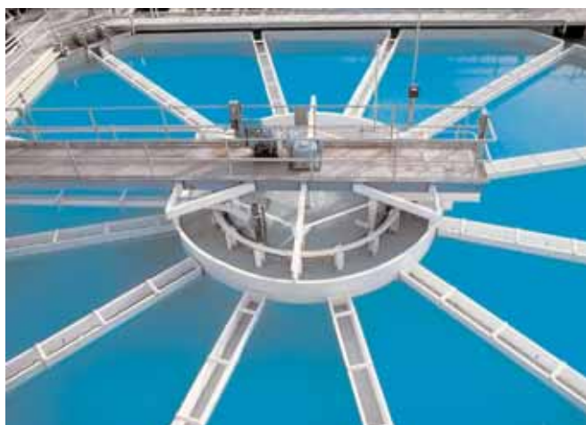
Un impianto di depurazione delle acque
