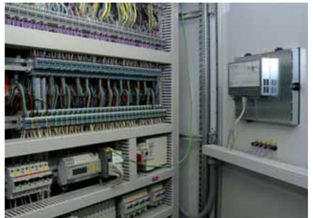
**Per le stazioni d'automazione sono stati utilizzati i PLC Saia PCD3.M5xxx e M3xxx completi di funzionalità Web**
