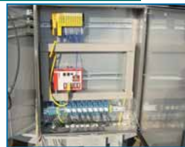
Il sistema di I/O decentrati PSSuniversal elabora i segnali a livello di campo in una struttura flessibile, modulare e compatta
