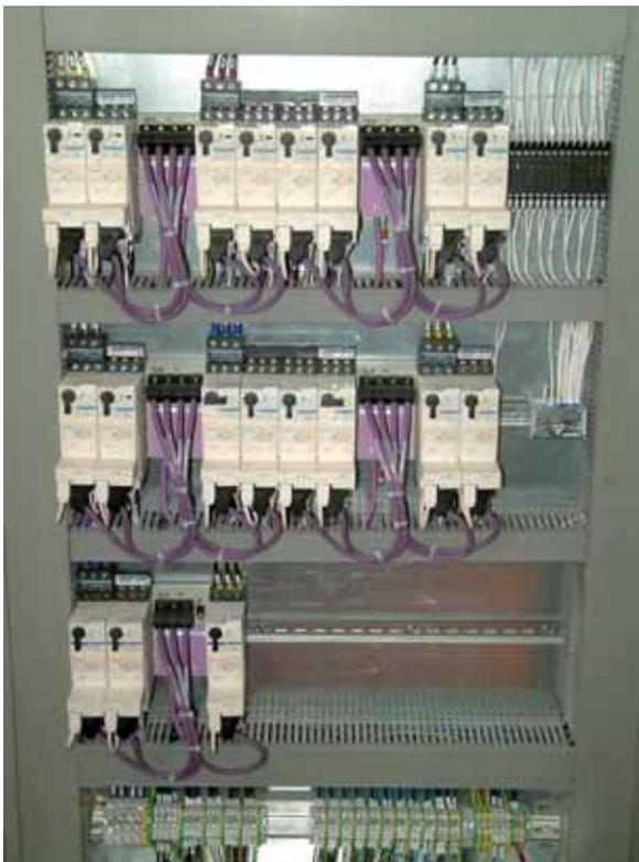
**I prodotti TeSys U Telemecanique sono stati scelti in quanto integrano tutti i dispositivi necessari al comando motore e presentano ingombri ridotti**
