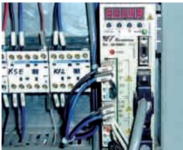
Per la parte di azionamento sono state utilizzate le unità Xtra Drive di Omron, una soluzione che sfrutta la possibilità di integrare il servoazionamento e la scheda controllo assi all'interno di un unico componente
