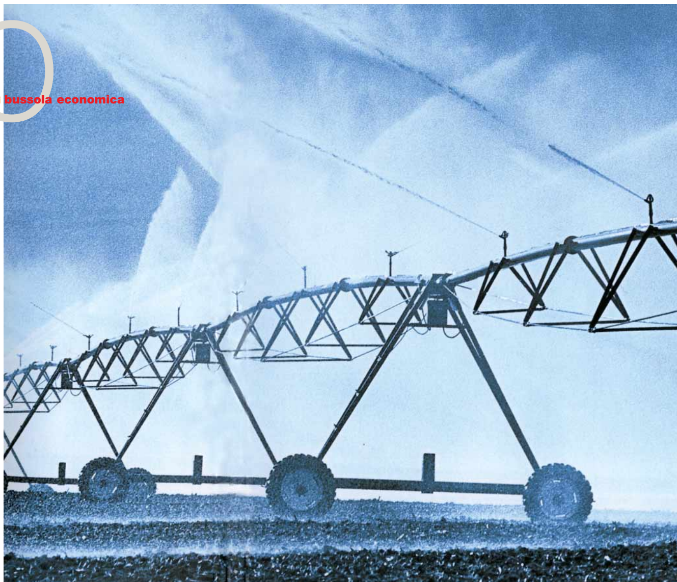
L'ottimizzazione della rete distributiva è un altro punto focale per ridurre gli sprechi d'acqua (Fonte: Siemens)
