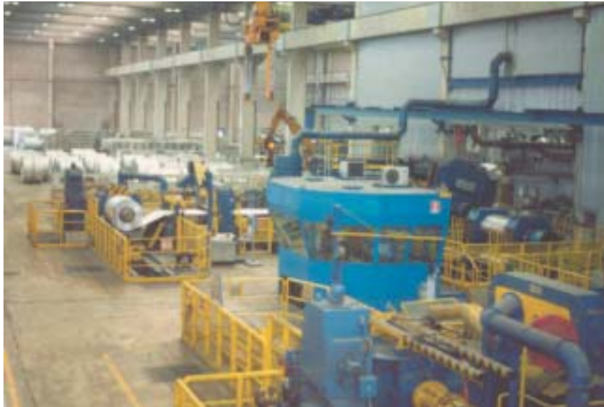
Le reti realizzate con componentistica Rockwell Automation permettono di controllare, da remoto, tutte le attività della linea
