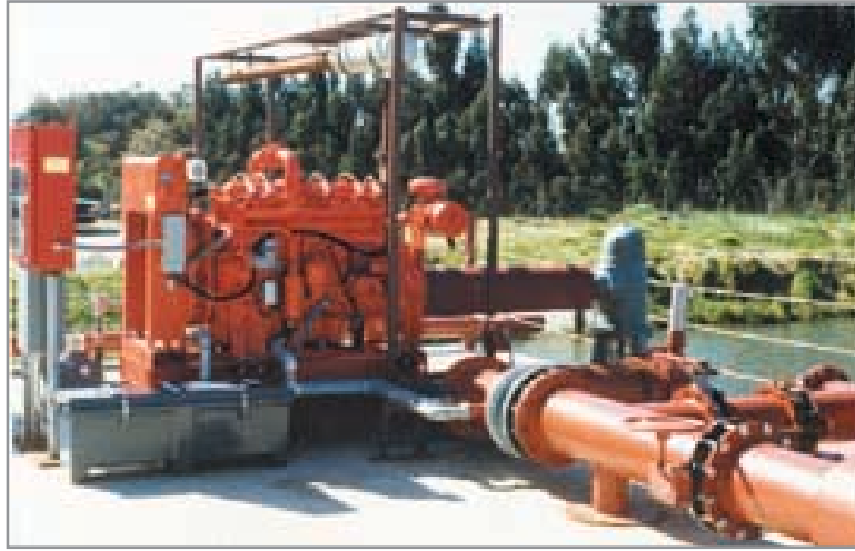
Fig. 6 - Le stazioni di compressione hanno il compito di trattare, pulire e comprimere il gas per imprimere l'energia necessaria a mantenere le condizioni di pressione e portata richiesti (fonte: Eni Group)
