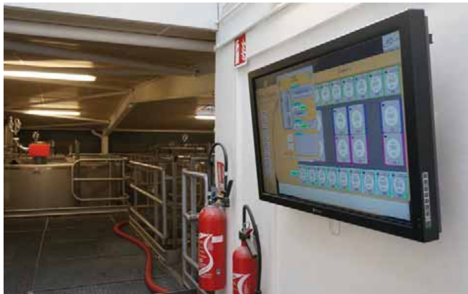
Gli operatori possono monitorare e controllare il software tramite un touchscreen 42" installato nell'atrio e alla portata di tutti i visitatori
