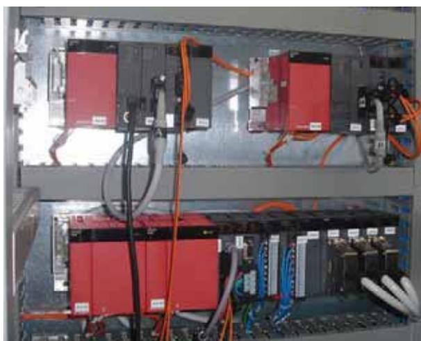
**Il PLC, i regolatori digitali e l'analizzatore di rete corrono su protocollo Modbus e si interfacciano con un pannello operatore GT16 della serie GOT1000, dove tutte le informazioni del sistema vengono acquisite e visualizzate**
