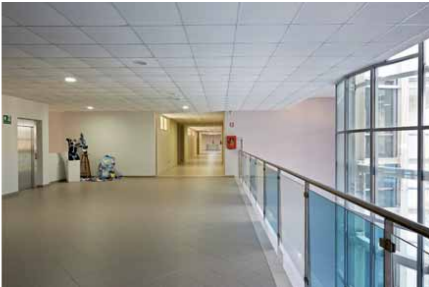
Al sistema di building automation di ABB fanno capo la gestione e la supervisione di tutti gli impianti dell'edificio
