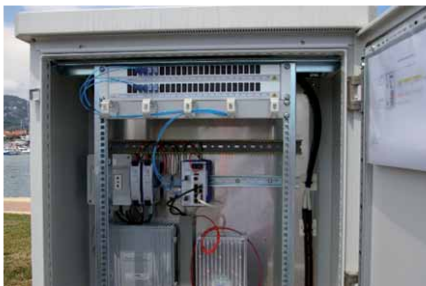
I contenitori serie CS di Rittal presentano resistenza a un range di temperature esteso e un livello di protezione fino a IP55, sono quindi adatti all'impiego in ambiente nautico
