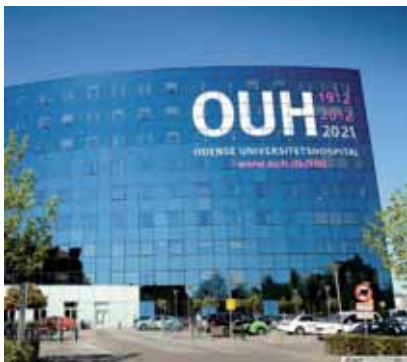
Nel complesso danese dell'Ospedale Universitario di Odense è stato installato un sistema di illuminazione basato sullo Dali-Color
