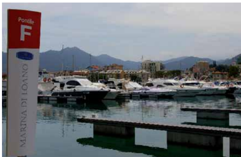
Tutte le banchine e i pontili della Marina sono dotati di colonnine erogatrici per fornire tutti i servizi necessari alle imbarcazioni
