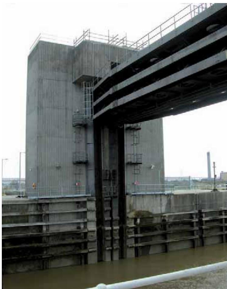
Viene impiegata una linea wireless come connessione di riserva automatica in caso di perdita della connessione in fibra ottica
