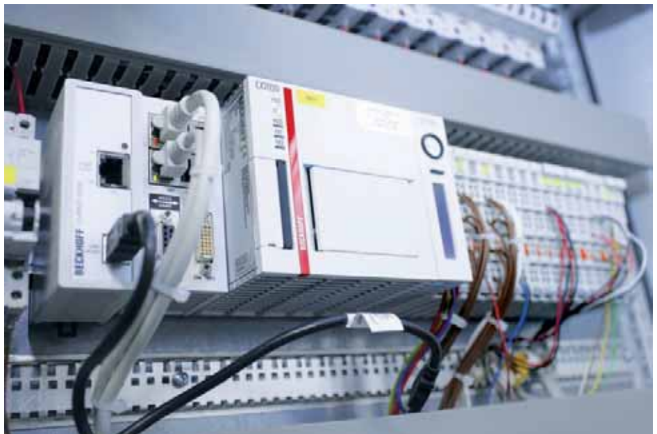
Il PC embedded CX2020 con CPU Intel Celeron e 1,4 GHz gestisce tutto un piano
