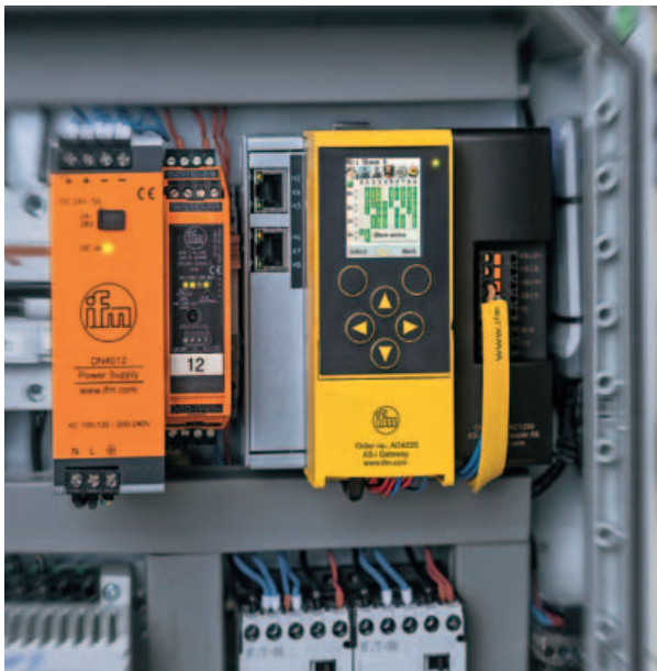
Come gateway AS-i, il sistema SmartPLC di IFM supporta il collegamento con Profibus, Profinet e EtherNet/IP
