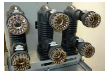
Sensori di temperatura Sensor serie S1 per elettrotecnica, applicati su interrutture mediante velcro
