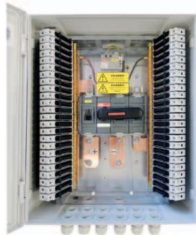
*Le installazioni fotovoltaiche possono essere dotate di sistemi che intercettano le correnti di fulminazione o le sovratensioni e le deviano verso terra, proteggendo pannelli e inverter*
