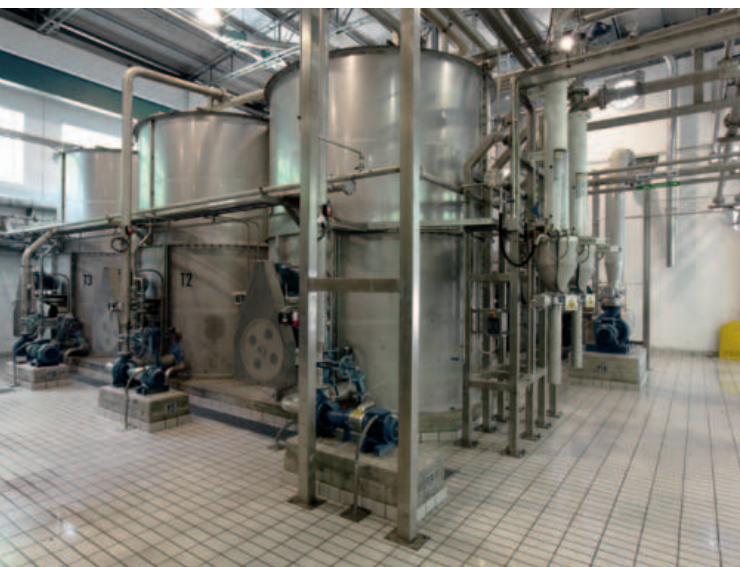
^ Presso la Cartiera di Pratolungo sono state installate diverse tipologie di pompe centrifughe Robuschi sia della famiglia Promix sia della famiglia Prochem
