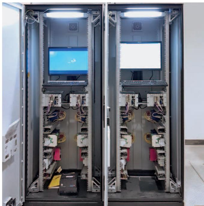
^ Le stazioni master Sima sono state scelte poiché in grado di fungere da controllore della rete di comunicazione e consentono la creazione di reti di attuatori autonome o di reti di secondo livello in un'architettura di controllo complessa
