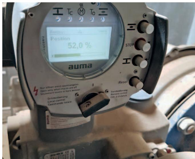
^ Le unità di controllo degli attuatori comunicano utilizzando il protocollo Profibus DP attraverso ben quattro anelli in fibra ottica
