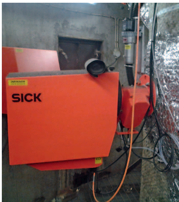
^ L'analizzatore di gas in situ GM35 è installato nel camino e rileva la concentrazione di CO 2 direttamente nel canale dei gas di scarico
