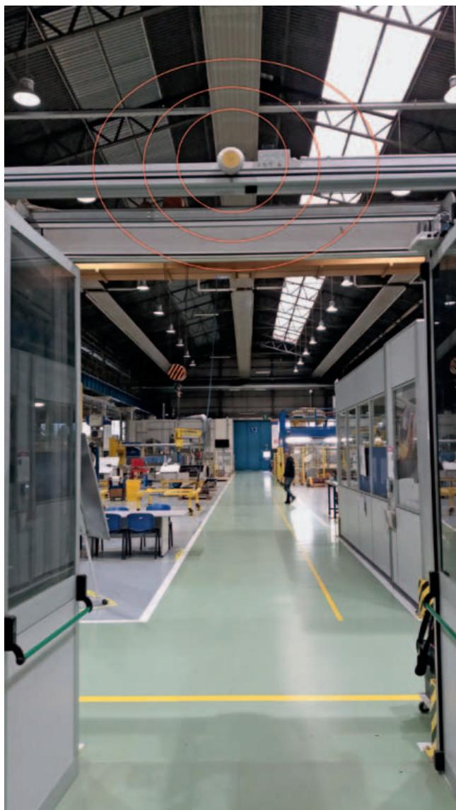
**I tag/beacon BLE, che trasmettono i dati agli EchoBeacon fissati a soffitto o a parete, sono stati apposti a ridosso dei varchi d'ingresso/uscita**
