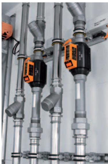
**Grazie all'interfaccia IO-Link sul contatore di aria compressa è possibile trasmettere anche messaggi di stato per l'ulteriore elaborazione**
