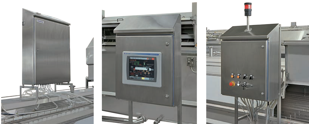
Componenti Rittal implementati: contenitori compatti Hygienic Design monoporta in acciaio Inox
