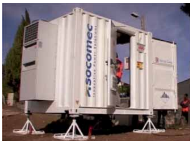
Container di 10 piedi fornito da Socomec per il progetto Nice Grid, nel quale sono alloggiati tutti i componenti richiesti per la regolazione intelligente della funzionalità di accumulo
