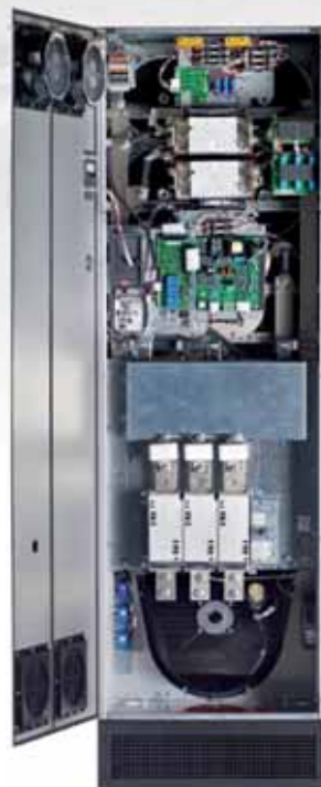
Il filtro attivo VLT AAF 006 utilizzato nell'aeroporto
