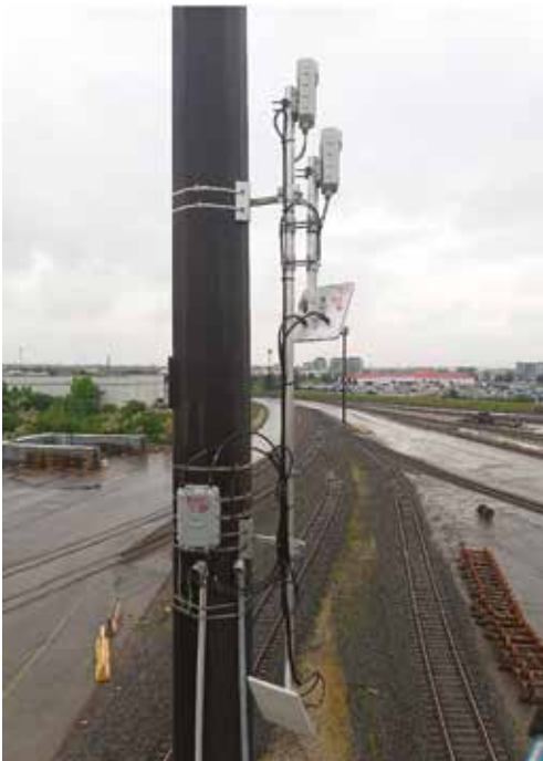
La rete realizzata consta oggi di 75 nodi cnWave a 60 GHz, che coprono un'area di circa 3,2 km di lunghezza e 0,4 km di larghezza
