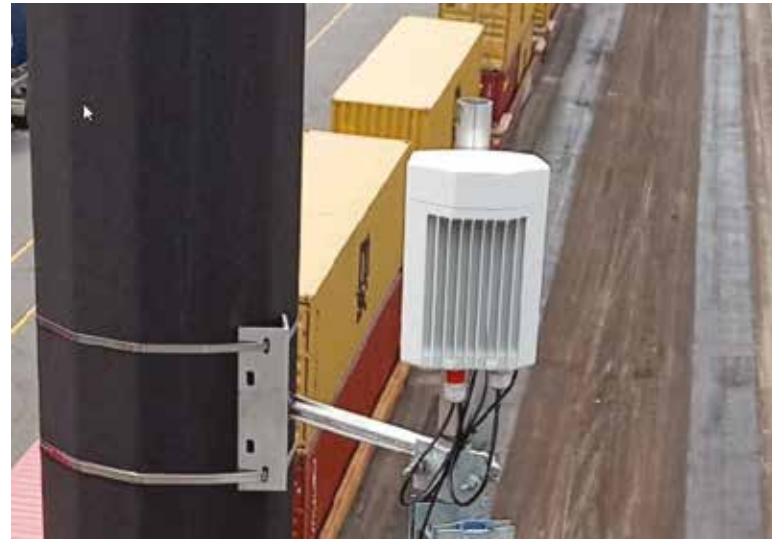
La maggior parte dei nodi dispiegati nella rete sono nodi di distribuzione cnWave V5000, che abilitano la tecnologia di rete mesh distribuita mmWave
