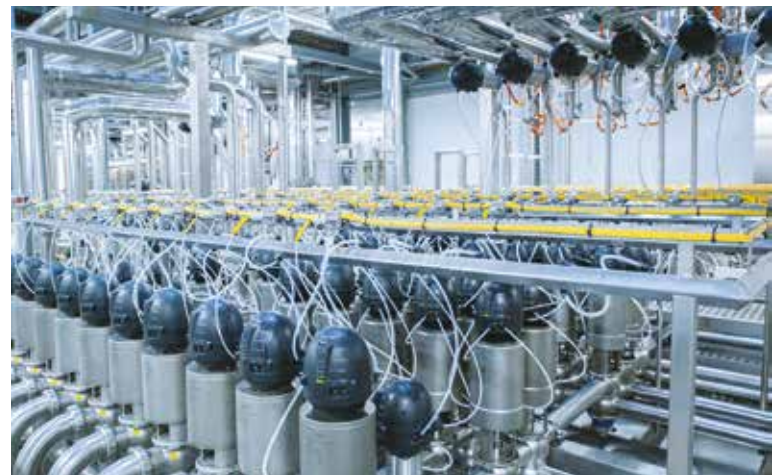
Nel progetto Refresco, AS-i è stato combinato con IO-Link: i sensori decentralizzati sono raggruppati tramite master IO-Link compatibili con AS-i
