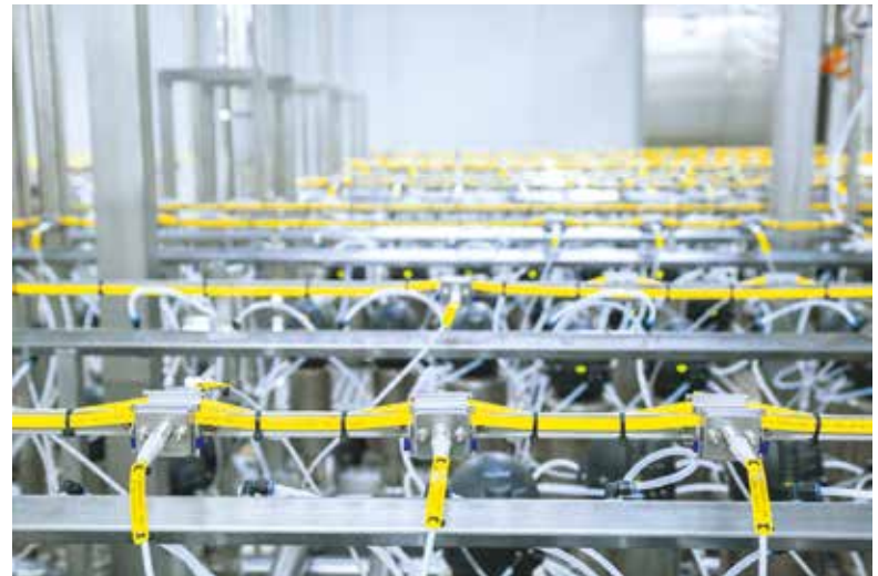
La lunghezza del cavo AS-i può raggiungere i 1.000 m con cavi e ripetitori standard o 3.000 m utilizzando cavi in fibra ottica
