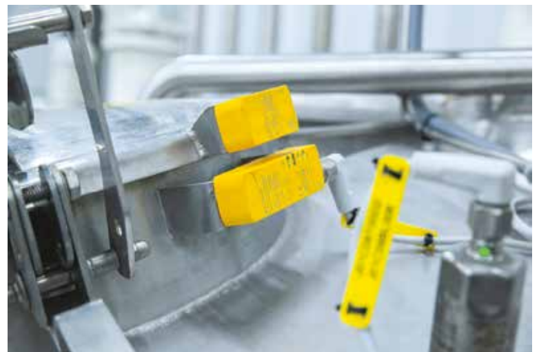
Per realizzare la rete della fabbrica Refresco France ha lavorato a stretto contatto con ifm, partner per la digitalizzazione
