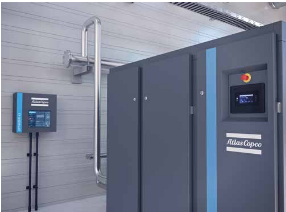
Fra i 4 compressori Atlas Copco dello stabilimento figura il modello ZR 160 VSD che permette la modulazione del carico in funzione delle necessità produttive
