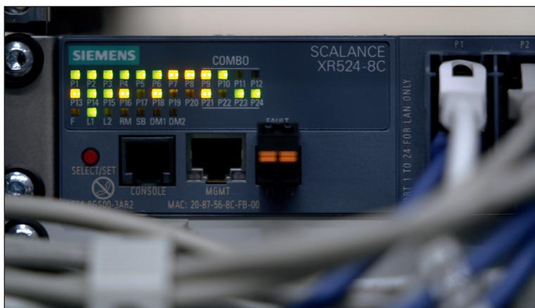
La rete Industrial Ethernet del birrificio conta circa 3.000 metri di cavi e circa 85 diversi componenti di rete Scalance di Siemens
