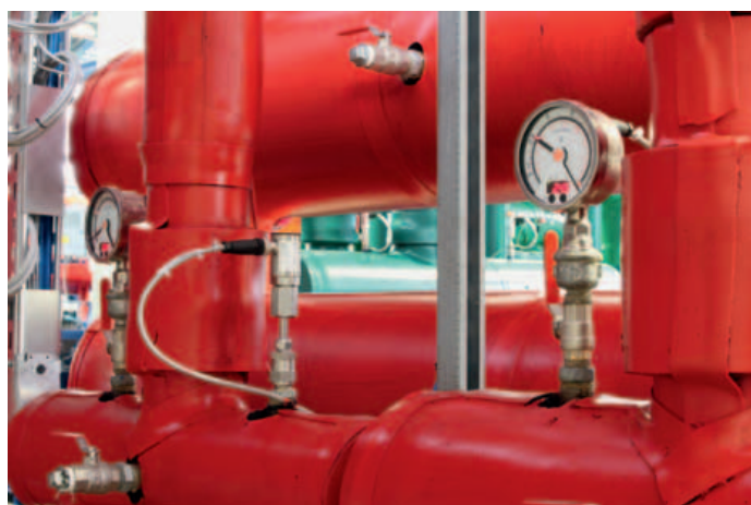
Il manometro elettronico controlla la pressione del sistema, i sensori TN misurano la temperatura
