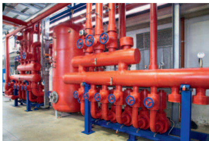
Impianto di trigenerazione completamente automatico
