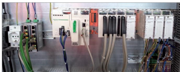
In particolare Corimpex ha impiegato l’ePAC Modicon M580, che integra nuovi backplane con connessione Ethernet diretta e nativa
