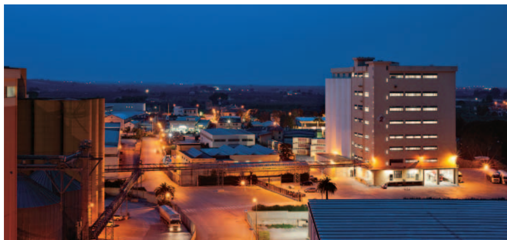
Per migliorare le prestazioni energetiche dei suoi impianti di lavorazione dei cereali, il Gruppo Casillo ha scelto di affidarsi a delle soluzioni meccatroniche di Siemens
