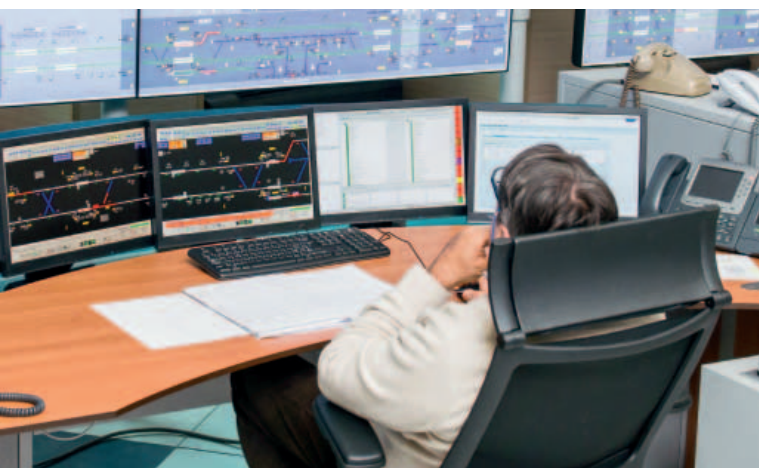
Le soluzioni di automazione di GE consentono di gestire un impianto idrico da un'unica sala di controllo
