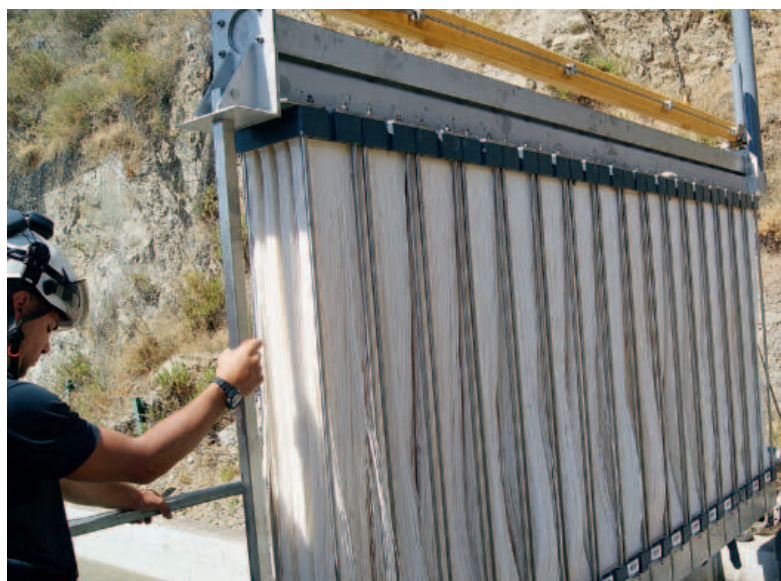
^ Nel depuratore di Taormina sono stati installati 96 moduli di membrane Zeeweed 500S
