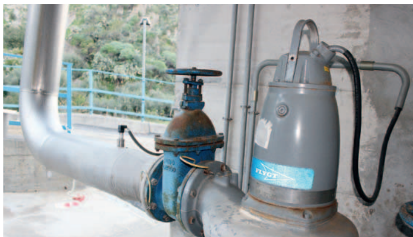
v La preparazione dei tecnici Xylem ha permesso di rendere funzionante l'installazione in poche settimane, salvaguardando la stagione estiva
