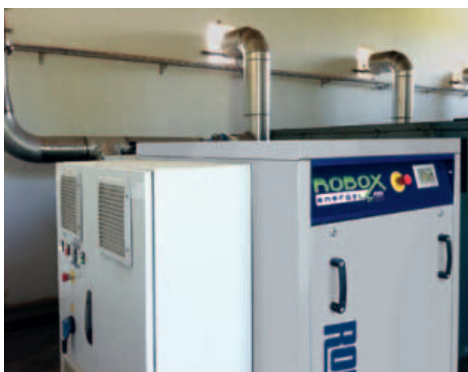
^ La tecnologia del compressore a vite Robox assicura una maggiore efficienza rispetto ad altre soluzioni disponibili sul mercato proprio grazie al particolare motore a magneti permanenti
