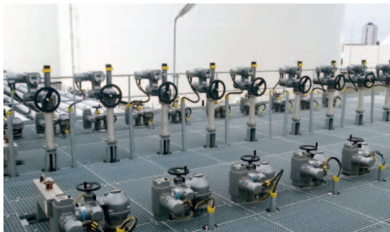
^ Gli attuatori Auma utilizzati al Terminal Koole Tankstorage Minerals di Rotterdam
