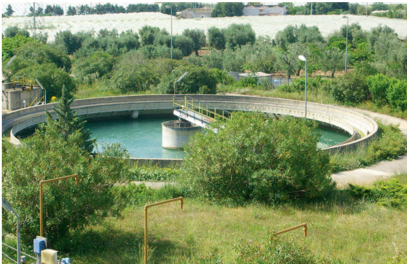
La piattaforma PlantPax di Rockwell Automation consente ad AQP di tenere sotto controllo i consumi energetici
