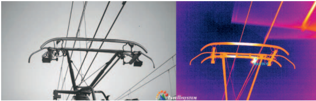
Confronto di un'immagine acquisita nel campo del visibile con una termografica per effettuare misurazioni di temperatura sul punto di contatto tra pantografo e linea aerea
