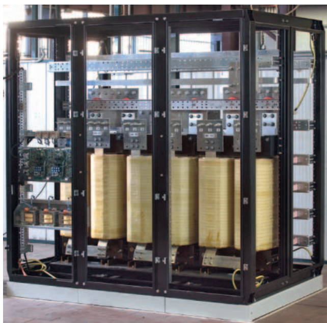
Lo stabilizzatore in allestimento
