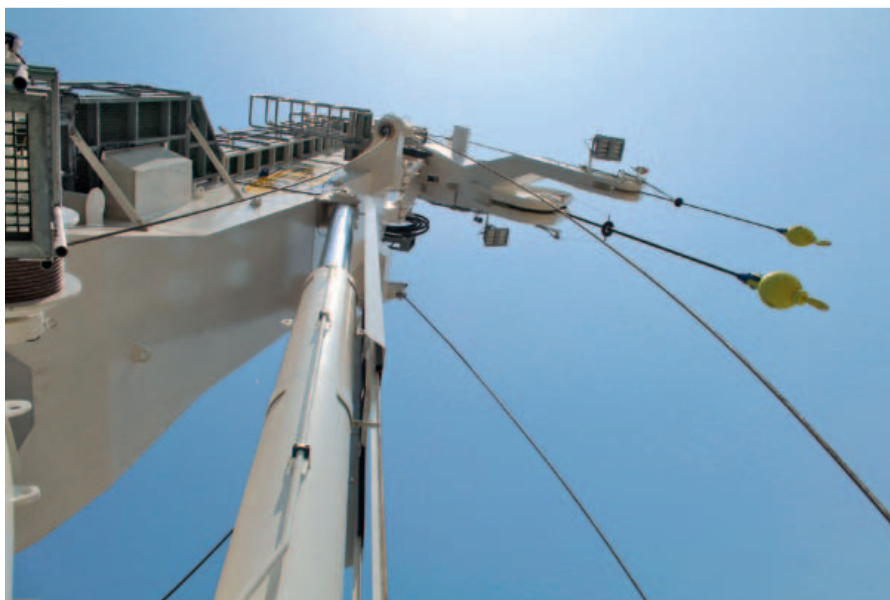
La soluzione di Eaton ha utilizzato un'innovativa architettura di controllo; Eaton ha anche fornito UPS e apparati di illuminazione
