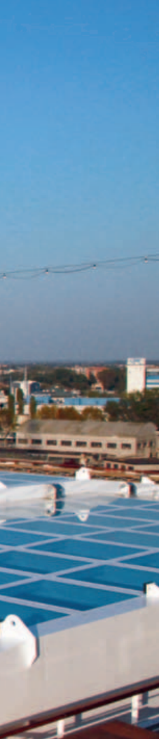
La parte strutturale della copertura Skydome è composta da pannelli scorrevoli, al cui esterno sono applicati speciali lastre di vetro e componenti anticondensa
