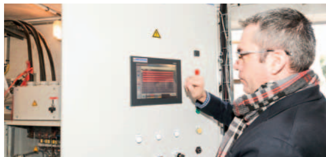
Il ricollegamento del quartiere alla rete pubblica avviene senza che gli utenti se ne accorgano
