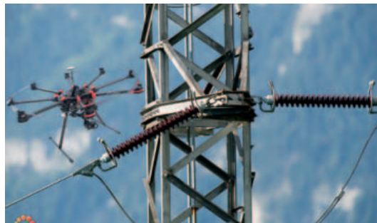
L'ispezione delle linee aeree di alta tensione con il sistema TID porta significativi benefici
