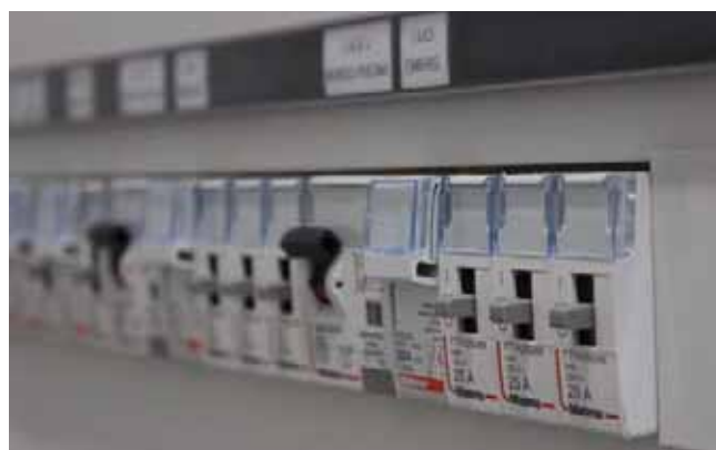
I quadri sono equipaggiati, oltre che dai dispositivi di protezione BTDin, anche da salvamotori e contattori della stessa linea
