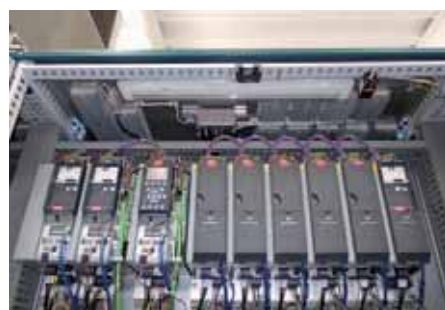
La soluzione VLT AutomationDrive FC302 controlla motori PM di tre marchi differenti
